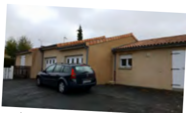
Nettoyage des façades et démoissage des toitures sur les logements communaux des Ouches aux Moines
