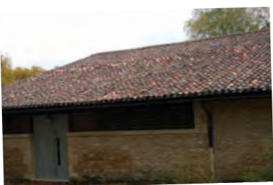
Réparation de la toiture du bâtiment de la Futaie
