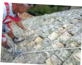
Réfection des lauzes de la toiture de l'église, abimées par le gel
